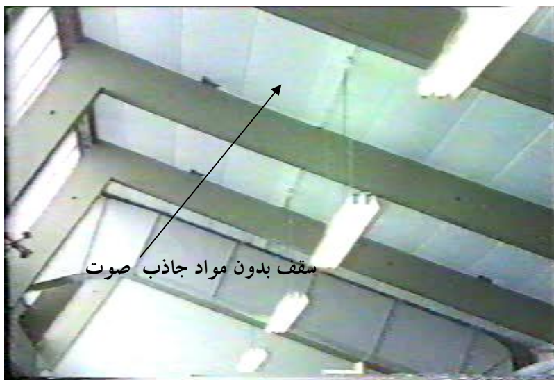
( سقف سالنی که ماشین برش در آن قرار دارد خود عامل انعکاس صداست )
